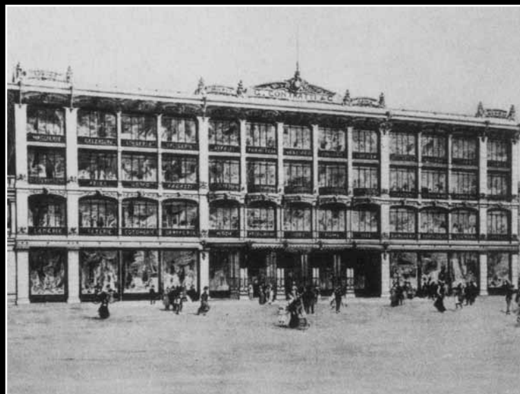
Luigi Broggi, Magazzini Contratti in via Tommaso Grossi 8, Milano, 1901-1903
