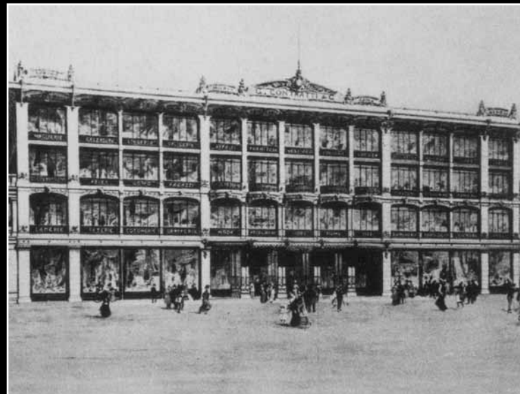
Luigi Broggi, Magazzini Contratti, via Tommaso Grossi 8, Milan, 1901-1903
